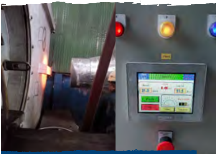
การเปลี่ยนหัวเผาบอยเลอร์ให้สามารถใช้กับเชื้อเพลิง Wood Pallet ได้
