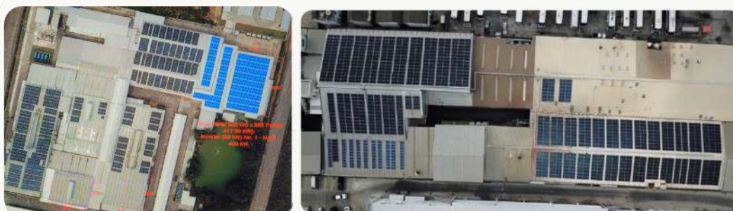
ภาพแสดงการติดตั้งแผงโซล่าบนหลังคา
