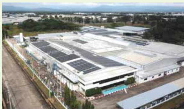
ภาพการขยายแผงโซลาร์ที่ติดตั้งบนหลังคาอาคารโรงงาน
