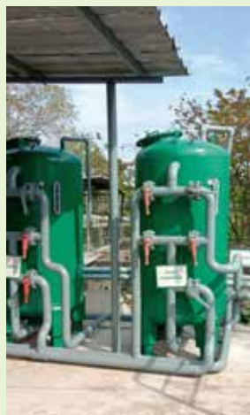
ภาพการติดตั้งระบบการนำน้ำทิ้งกลับมาใช้ใหม่
